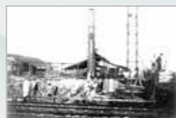
建設中の宇部セメント製造(大正13年)
